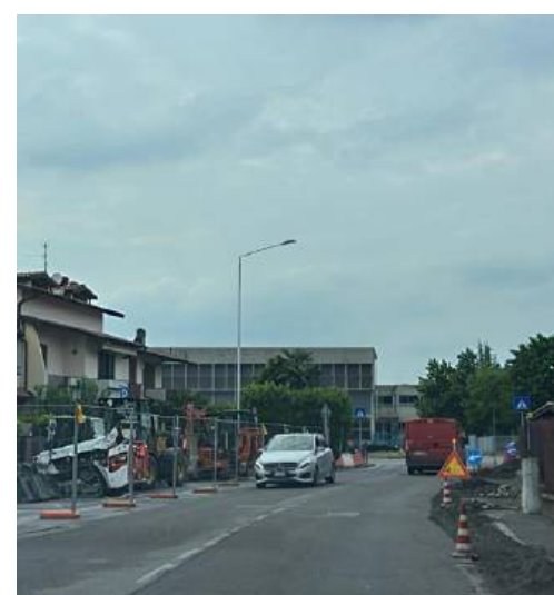
Lavori in corso nella strada del quartiere Primavera
